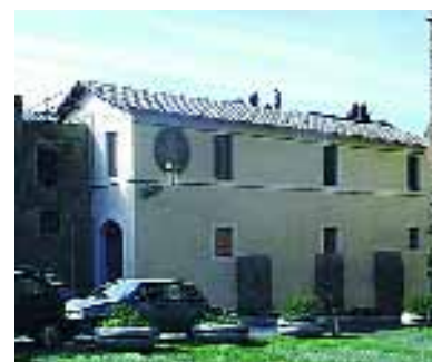
Sede RTI al Celio, restauro di facciata
