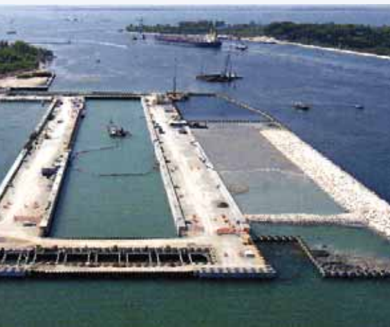
Bocca di porto di Malamocco, interventi per la costruzione della conca di navigazione che consentirà il transito delle grandi navi anche a paratoie alzate
