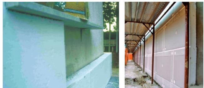
Fig.3: esempi di isolamento perimetrale a cappotto
