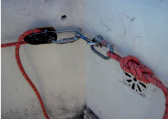
Particolari dell'ancoraggio della fune salvavita su parapetto di un terrazzo praticabile condominiale durante i lavori in quota.
