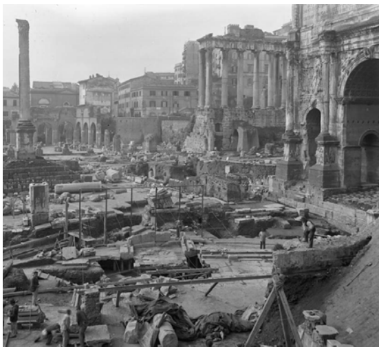
Area del Foro Romano durante gli scavi di Boni
